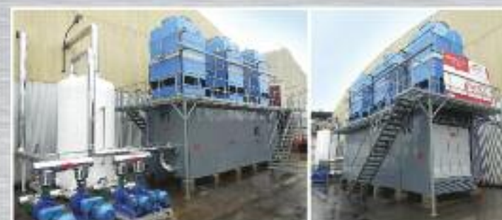
Unidad insonorizada tipo satélite de enfriamiento de glicol para línea de envasado de bebidas carbonatadas.
