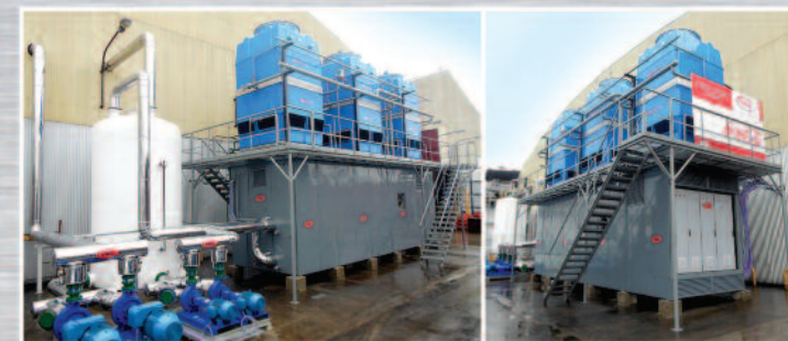
Unidad insonorizada tipo satélite de enfriamiento de glicol para línea de envasado de bebidas carbonatadas.
